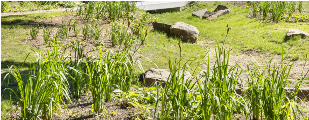
Abbildung: Versickerungs-/Retentionsmulde im Park Welheim
